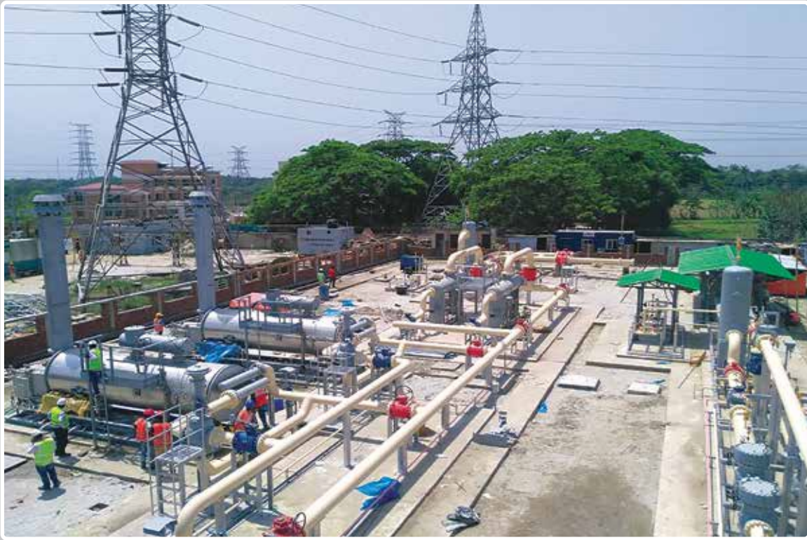
ভেড়ামারা ৩৬০ মেঃওঃ সিসিপিপি আরএমএস
